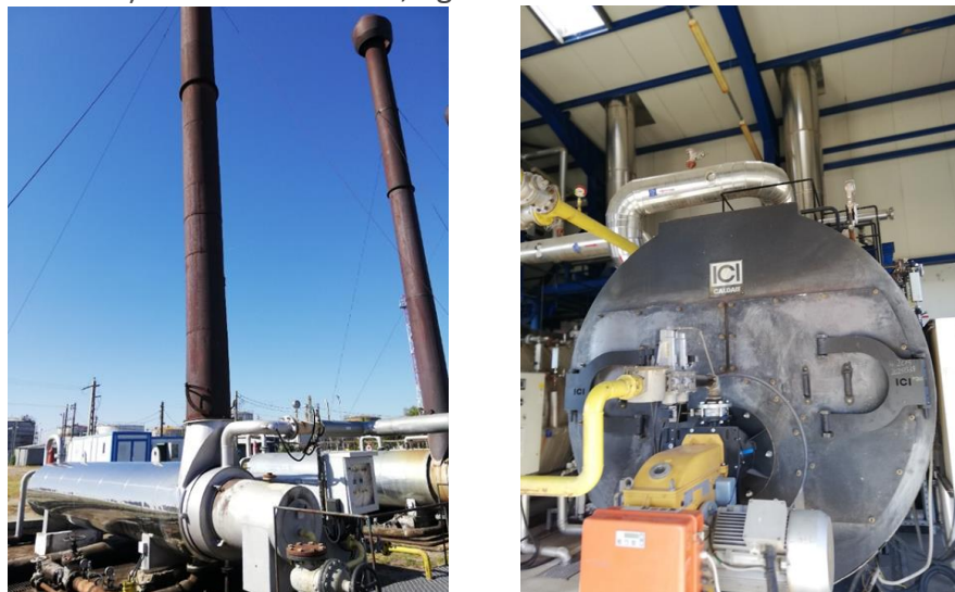
Fig. 2.14. Un încălzitor cu flacără directă și un cazan de abur.
